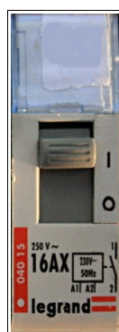
Commande manuelle du télérupteur sur position 0 ou 1
