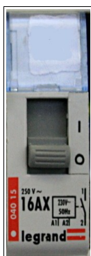
Commande manuelle du télérupteur sur position 0 ou 1
