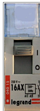
Commande manuelle du télérupteur sur position 0 ou 1
