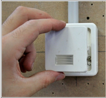
Appareillage Legrand-Plexo en cours de montage et tube IRO
